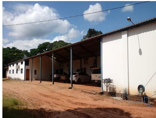
Figura 4. Pavilhão com a vista para o pavilhão e sala de aula.
